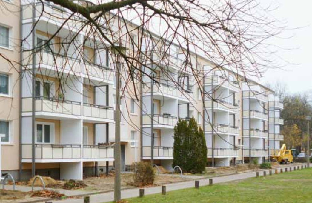
Die neuen Balkone in der Rudower Straße
