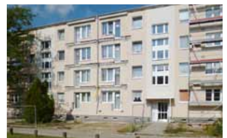
Während des Balkonbaus in der Köllnischen Vorstadt
