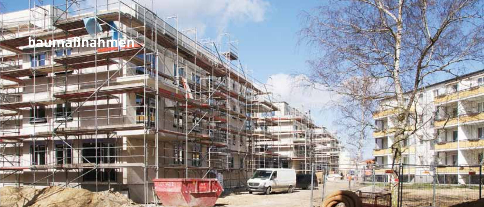
Drei weitere Häuser entlang der Bohnsdorfer Straße erweitern nun unseren Bestand in Grünau.
