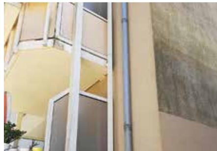
Auch Wärmedämmung befördert deren Wachstum. Aufgrund der geringen Wärmeleitung von innen nach außen, kommt es durch den Temperaturunterschied vornehmlich in der Nacht zur vermehrten Bildung von Kondenswasser. Durch die Dämmschicht erfolgt kein Wärmeaustausch (was ja dem Sinn der Wärmedämmung entspricht). Die Putzschicht hat ein sehr geringes Wärmespeichervermögen. So kann es vorkommen, dass die Lufttemperatur höher ist und die Luftfeuchtigkeit sich als Kondenswasser an der Fassade niederschlägt.
