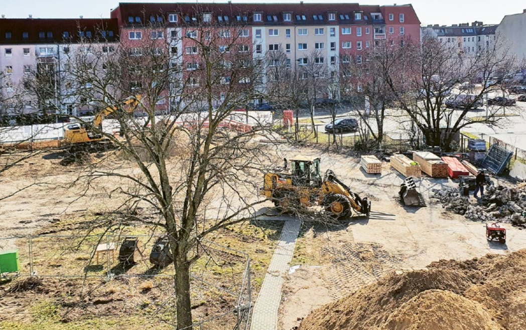
Das Baugeschehen mit Blick Richtung Glienicker Straße.
